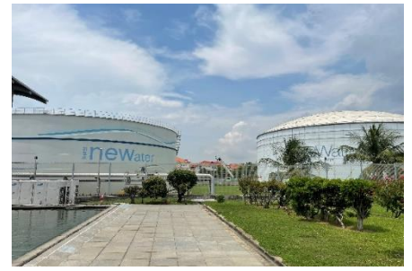
下水再生水“Newater”の処理工場
