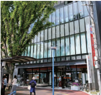
大橋駅前支店・大橋支店
