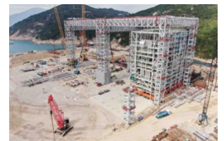
ランタオ島の南沖で建設が進む 廃棄物発電施設「L. PARK1」 出所：香港政府新聞網
