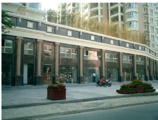
建設中の商店街
