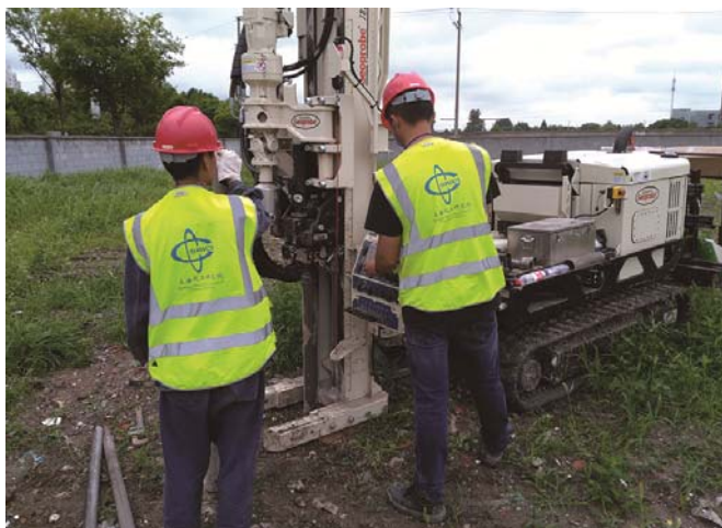
中国華東地区の工業用地におけるボーリング調査の様子
