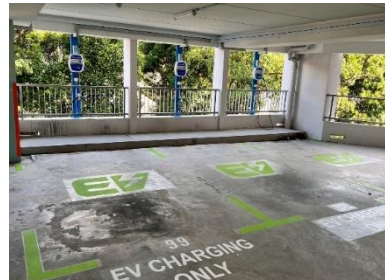
公共住宅駐車場の EV 充電スタンド
