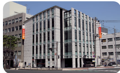
下関支店（平成25年4月新築建替）
