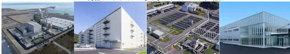
苅田バイオマス発電所 電気計装工事
