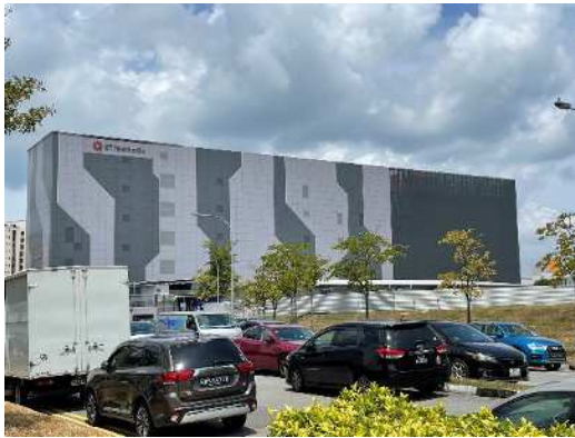
地場事業者の大型データセンター（2022年2月撮影）
